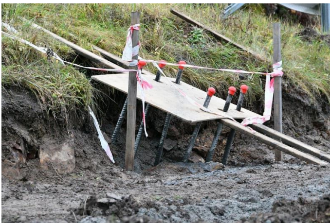
Boltene er montert i gysemasse og holds i posisjon med malplate.
