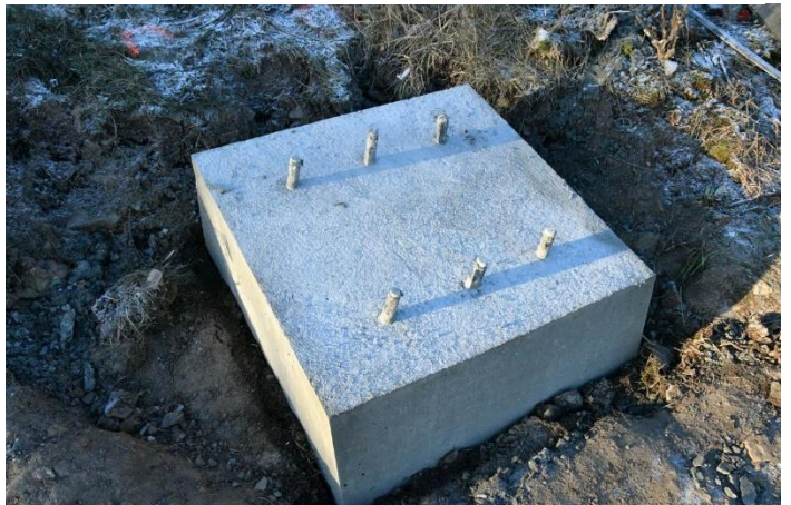
Tv Søndre Th Nordre forankringspunkt, Ferdig støp og overflaten er glattet og plan. Forskalingene er revet.
