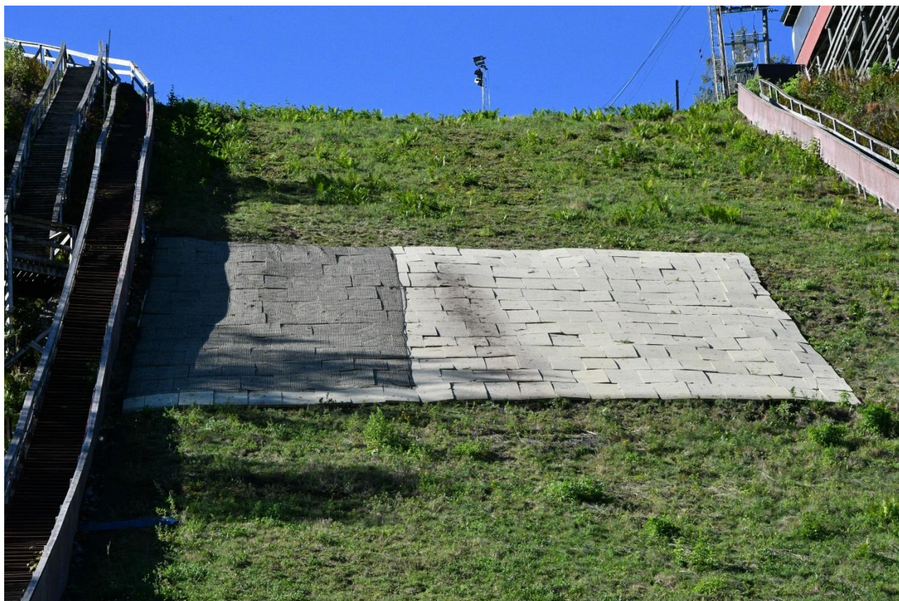
Tildekning av markplatene med geonett feste med kramper til bakken.
