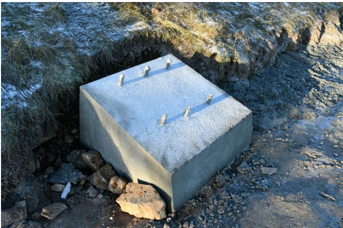
Tv Søndre Th Nordre forankringspunkt, Ferdig støp og overflaten er glattet og plan. Forskalingene er revet.
