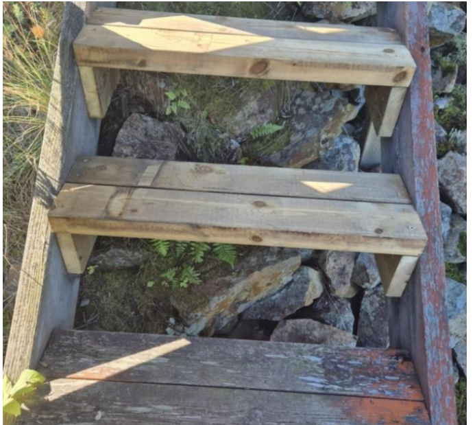
Tolv tretrinn i nordre måletrapp av tre er skiftet. Her er vist to av disse. (Foto Cany bygg).
