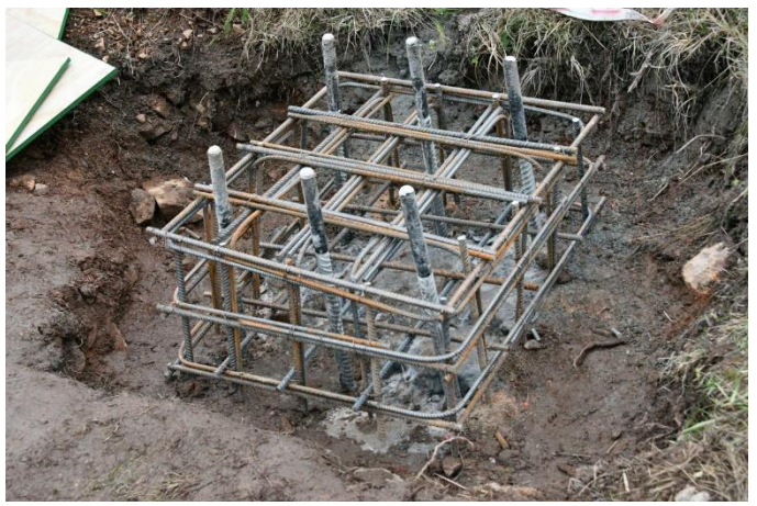
Armering av sokkelen. Klar for forskaling.
