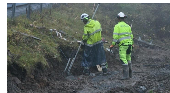
Borehullene fylles med gysemasse og boltene monteres
