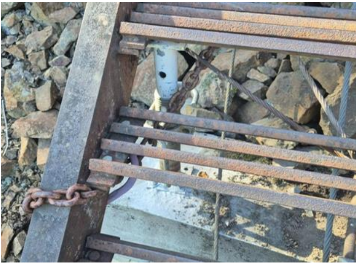
To par stålstøtter under søndre stålmåletrapp er rettet opp og innfestet på nytt. (Begge foto Cany bygg)
