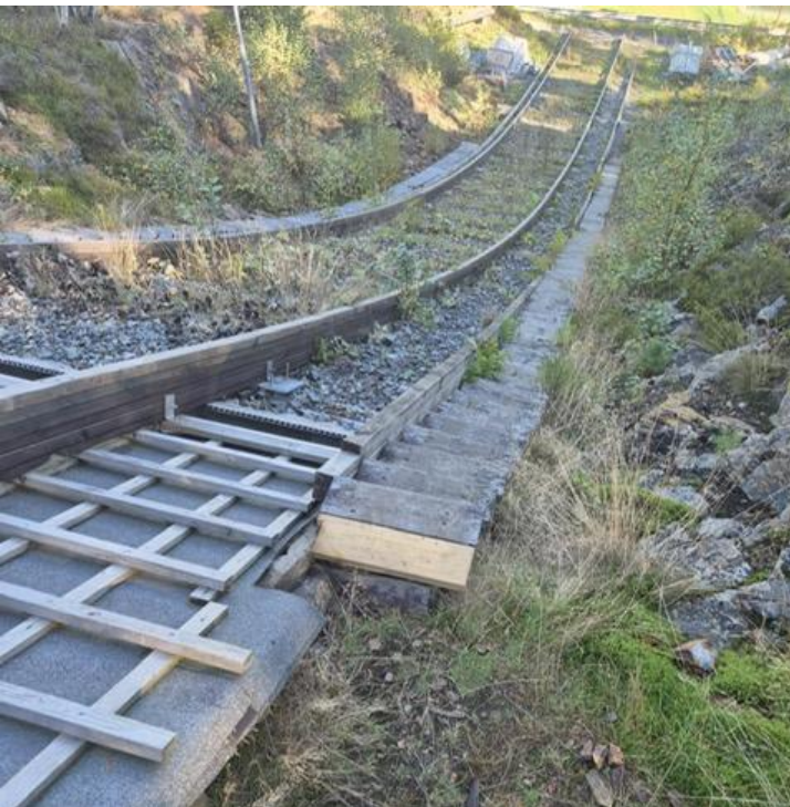
Tre stk. tretrinn i prepareringstrappene langs tilløpet til hoppet er skiftet.
