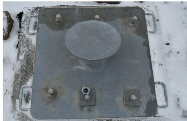
Oppvarming og fjerne is før legger på frostsikker ekspanderende understøp for montering av konsollene.
