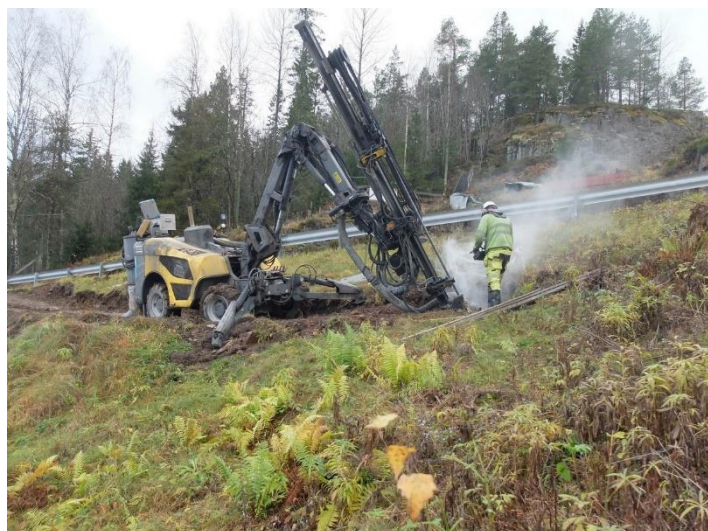
Boring ble utført med en selvgående borerigg 4x4
