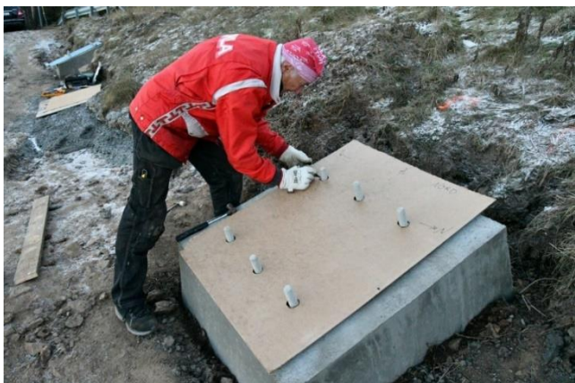
Oppmåling av bolteplasseringer og vinkler for mal til plasseringen av hullene i konsollene og skråvinkler på skivene.
