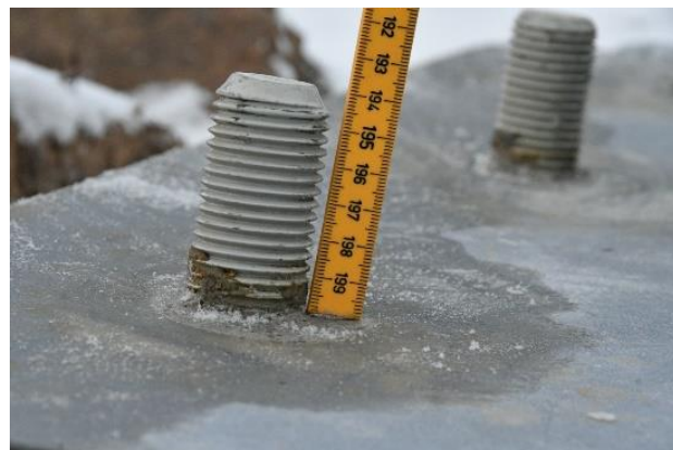
Oppmåling av bolteplasseringer og vinkler for mal til plasseringen av hullene i konsollene og skråvinkler på skivene.
