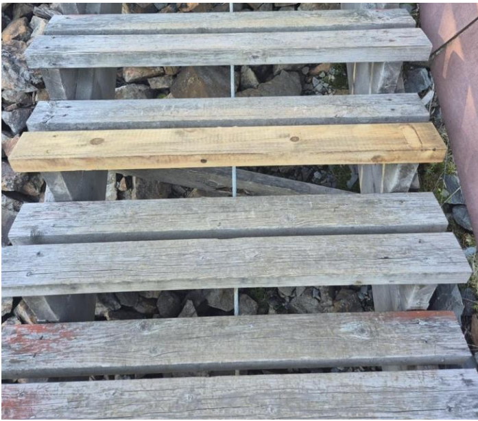
To trappetrinn av tre i søndre måletrapp nedre del er skiftet. (Foto Cany bygg)
