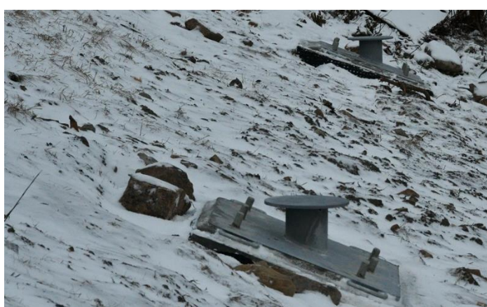
Oppvarming og fjerne is før legger på frostsikker ekspanderende understøp for montering av konsollene.
