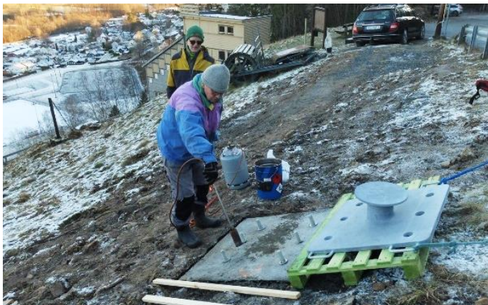
Oppvarming og fjerne is før legger på frostsikker ekspanderende understøp for montering av konsollene.
