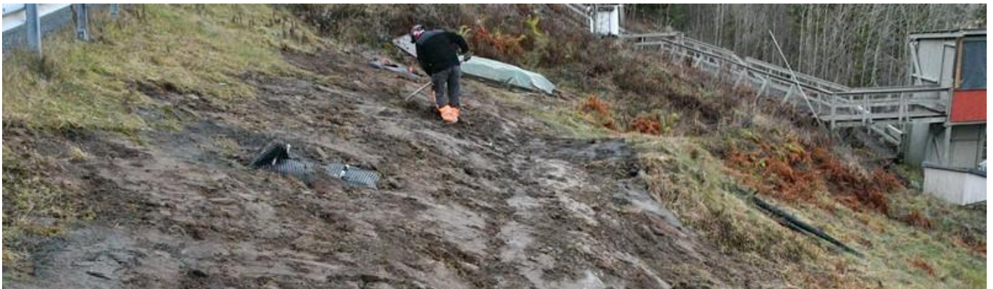
Forankringspunktene er kledd med grunnmurplate og massene tilbakefylt og jevnet ut.
