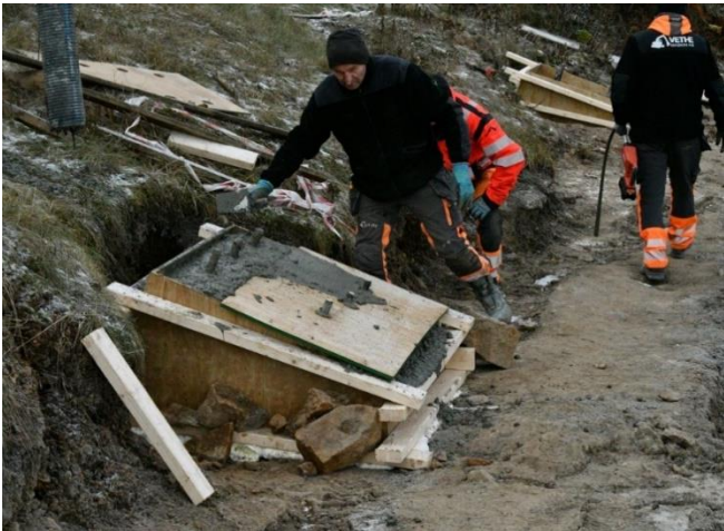
Tv. Søndre forankringspunkt støpes. Th Nordre forankring. Støpen ble levert ferdigblandet med betongbil for å sikre spesifisert kvalitet og styrke på støpen.
