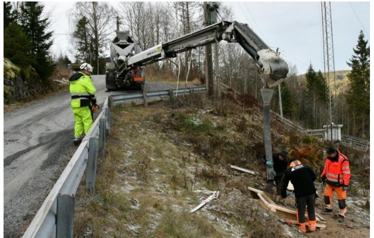
Tv. Søndre forankringspunkt støpes. Th Nordre forankring. Støpen ble levert ferdigblandet med betongbil for å sikre spesifisert kvalitet og styrke på støpen.
