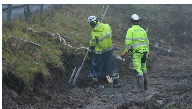
Borehullene fylles med gysemasse og boltene monteres
